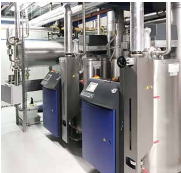
Ilustracja: stacja wielowytwornicowa w zabudowie modularnej
